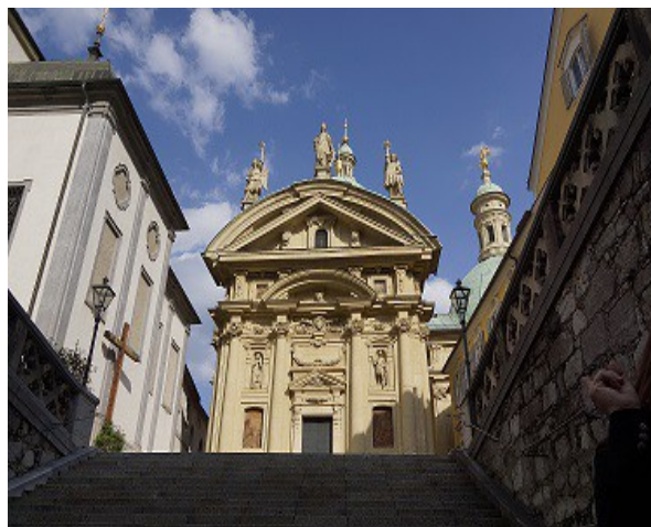
Il Duomo di Graz: facciata
